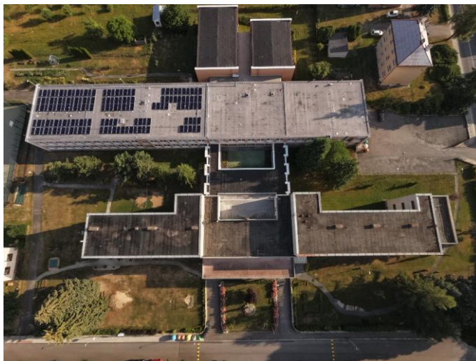
Zateplení střechy a instalace FVE
