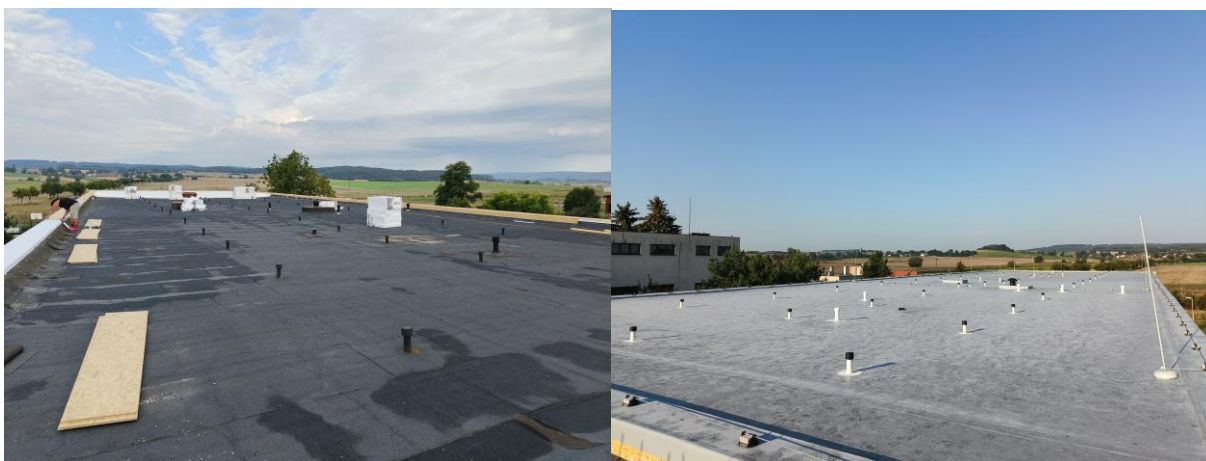
Rekonstrukce střechy – novější přístavba školy (zateplení a příprava pro instalaci fotovoltaiky).
