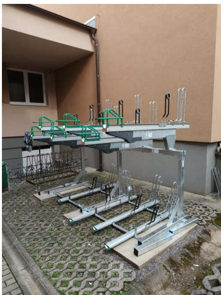
Průběh instalace stojanu na jízdní kola - spolupráce se společností WSM - Czech Republic s.r.o. na podpoře aktivního pohybu a ekologizace provozu v ZŠ Březnice.
