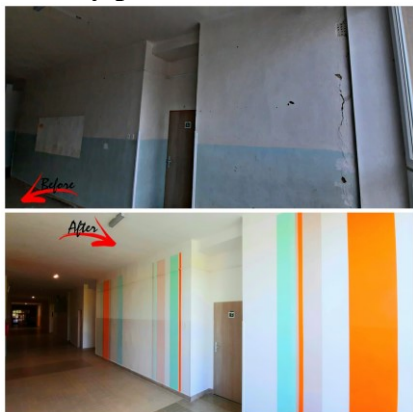
Ukázka rekonstrukce chodeb (novější přístavba školní budovy).
